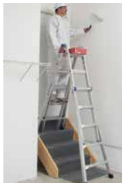
POSITION #2 Stairway Stepladder
